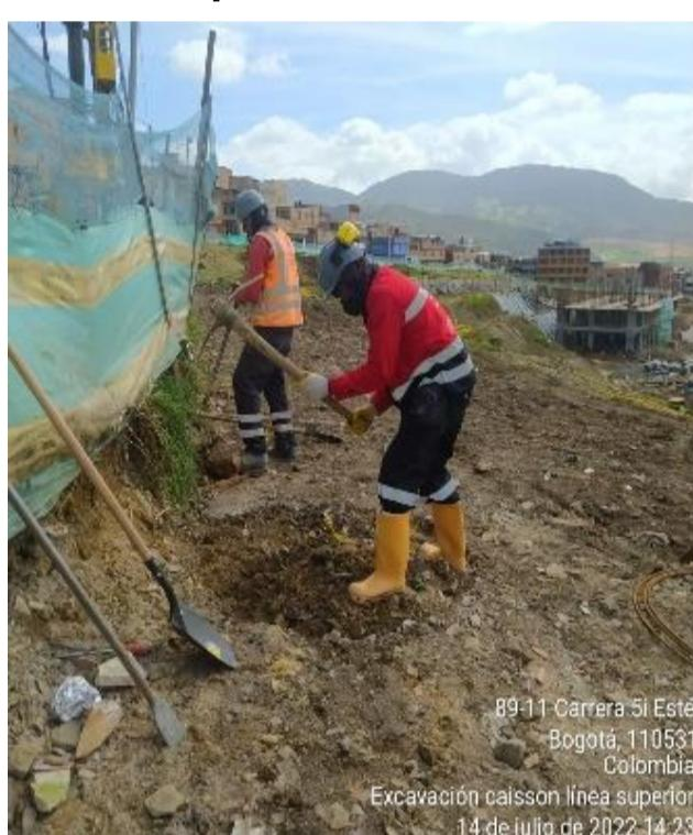
Se realiza la actividad de excavación manual para la construcción de caisson, o línea superior del muro de contención, en el costado sur de la obra, para ir estabilizando el terreno.
